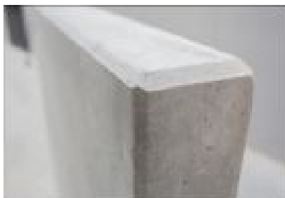
Ilustracja. Beton licowy wykończony na gładko, z fazą
