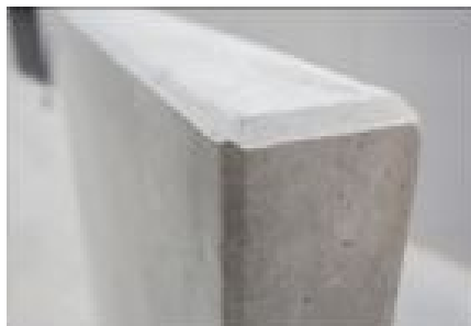
Ilustracja 13. Beton licowy wykończony na gładko, z fazą
